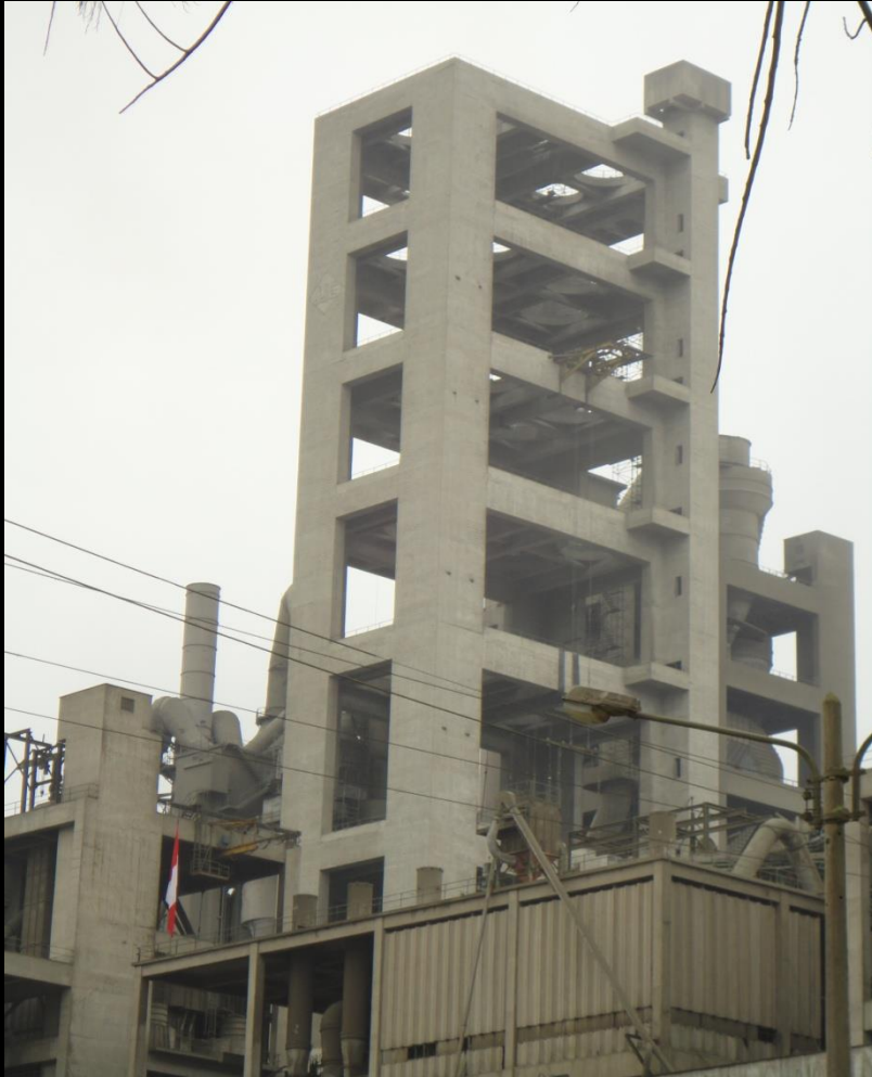
Intercambiador de calor - CEMENTOS LIMA
