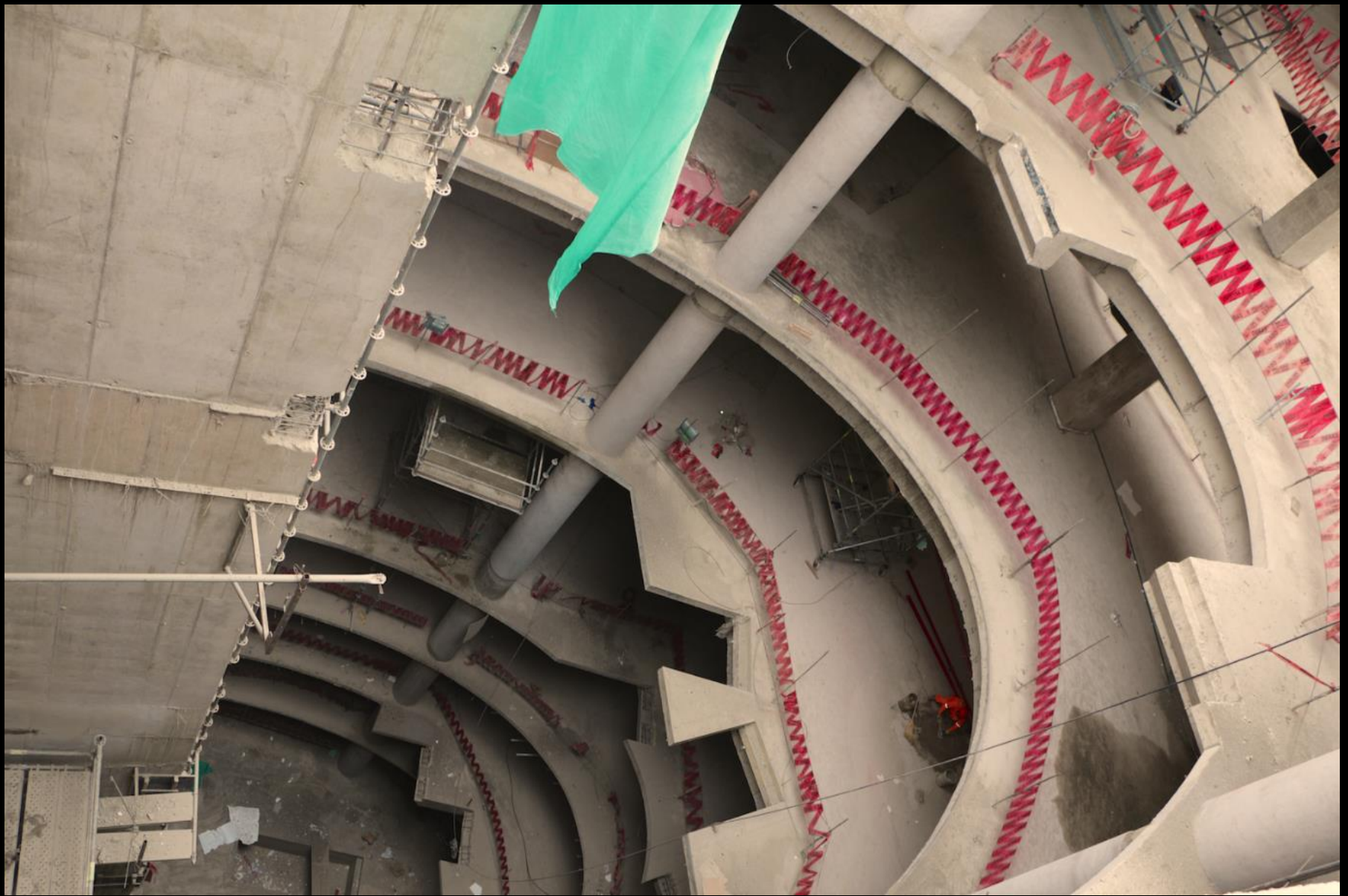
Vista del Atrio Central, se aprecian los puntos de apoyo de escaleras mecánicas en losa y sobre la izquierda, lateral de la caja de ascensores.
