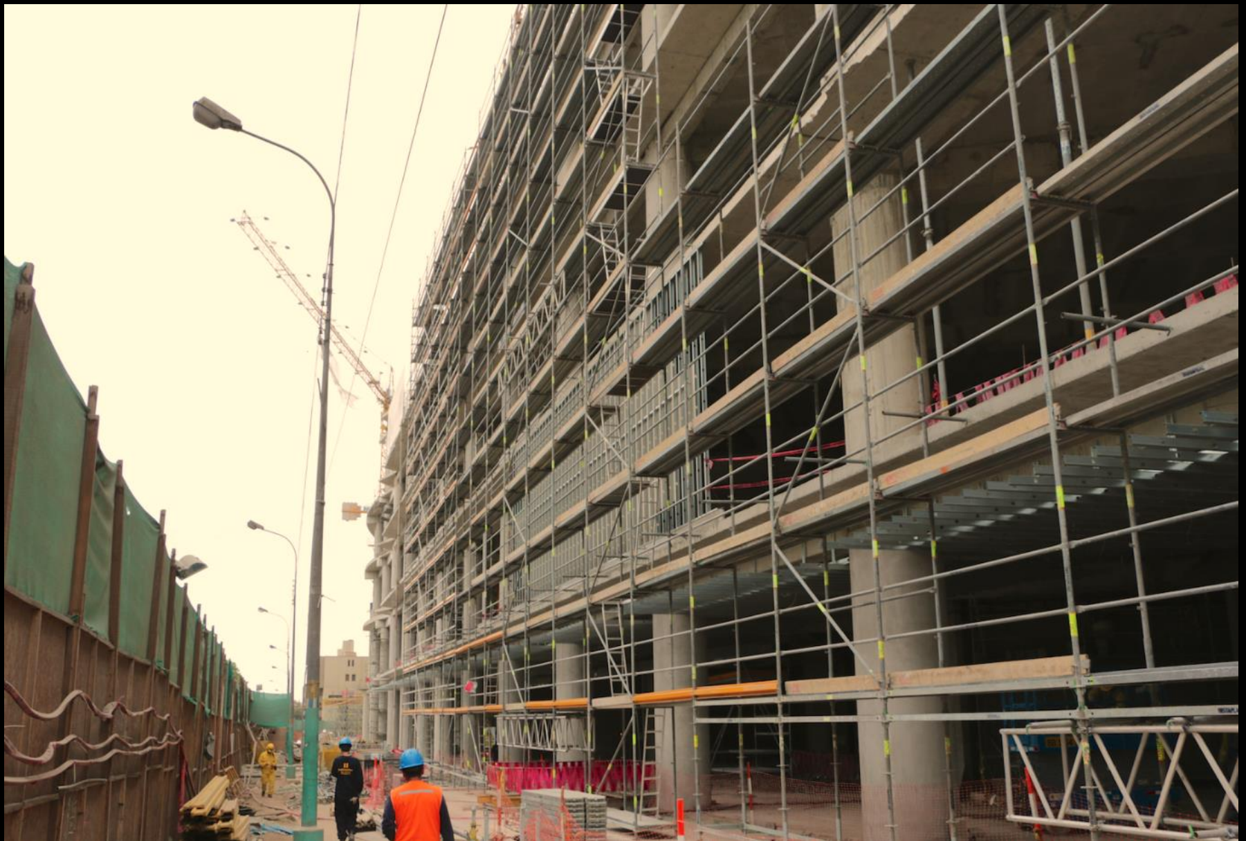
Vista de la Obra desde la fachada de la Avenida Salaverry.
