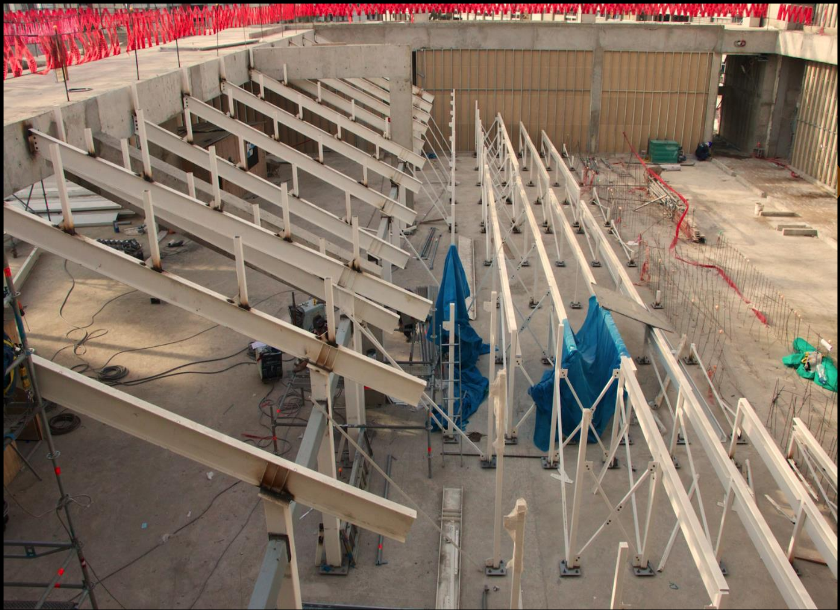
Vista del sector de Cines en el N.+17.50. Habilitación de las graderías mediante elementos metálicos anclados a la losa del piso, entre ejes 9/15A y C/F.
