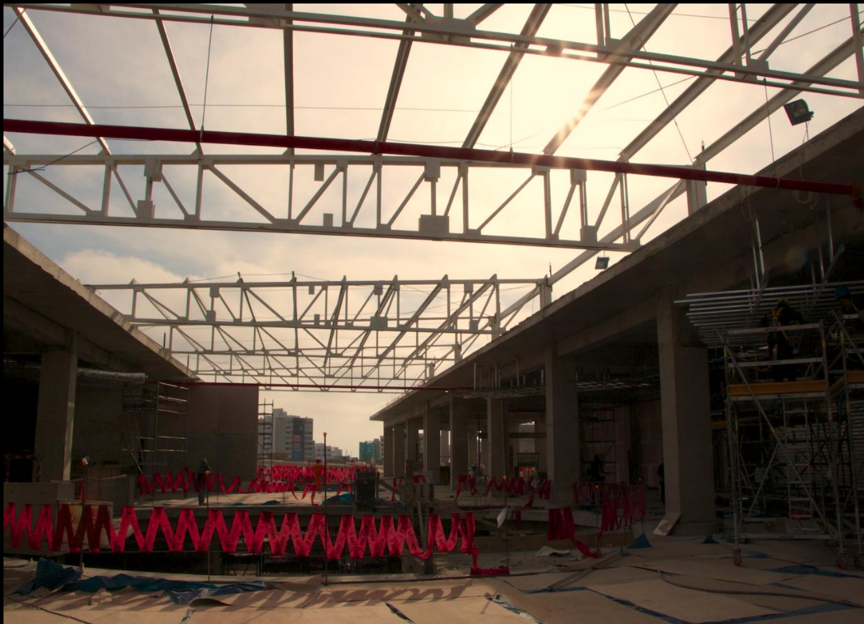
Estructura metálica de cobertura entre los ejes 16/21 y G/I.
