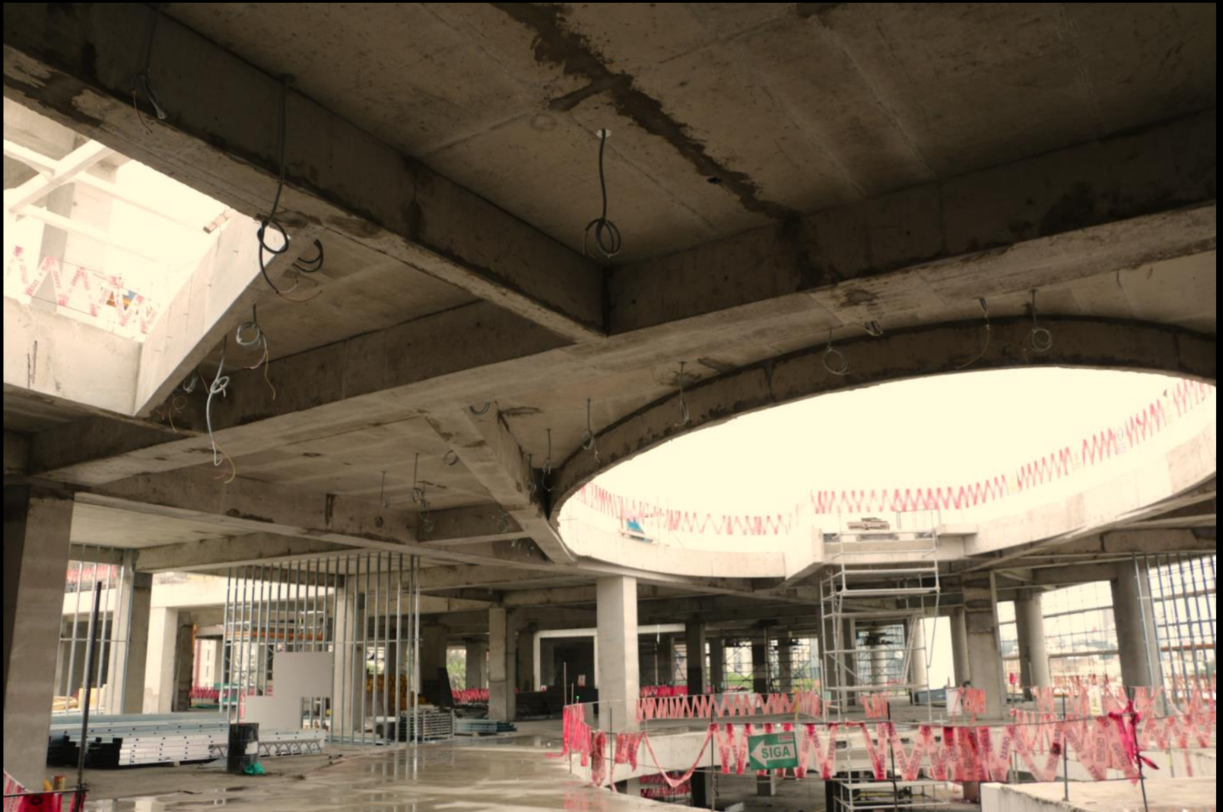
Otra vista de losas de techo con vigas diagonales y pases.
