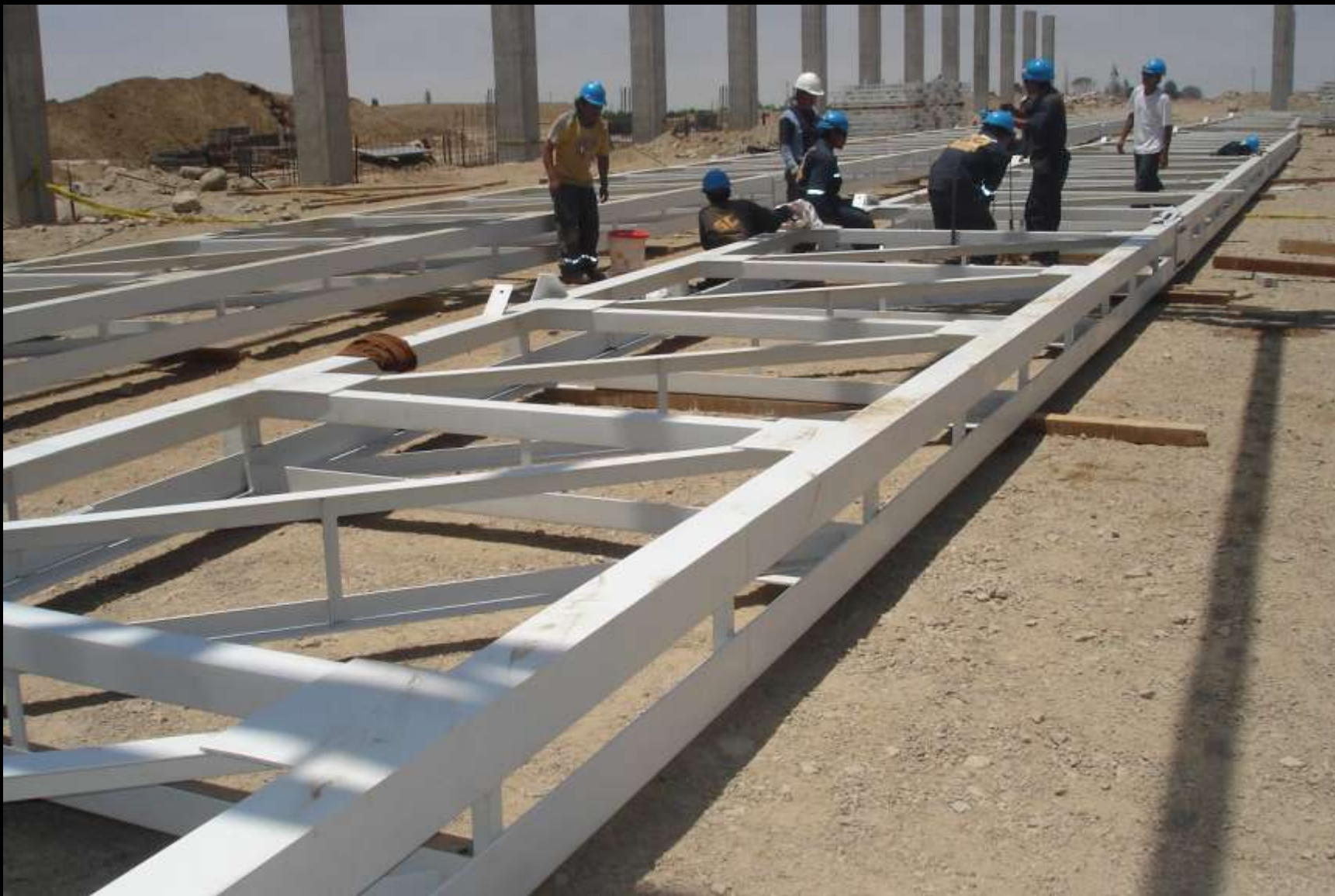
Sección de Armadura de 50m antes del izaje.
