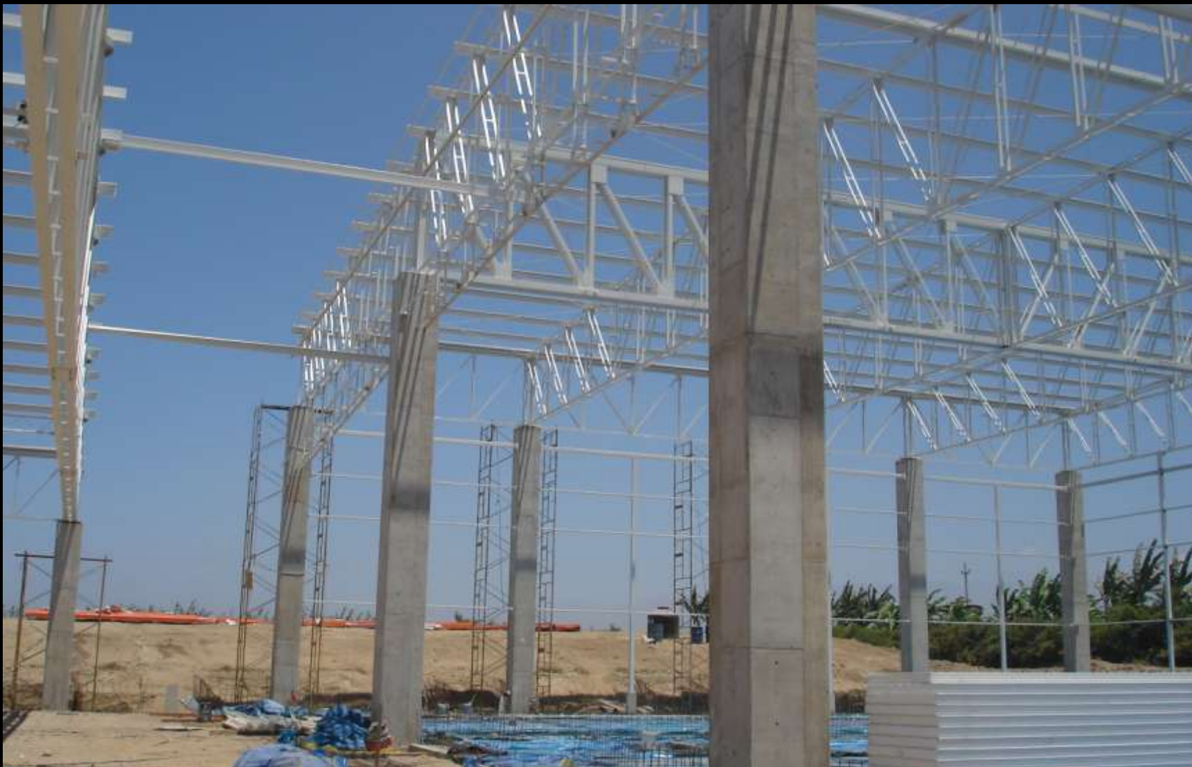
Ejes 23 y 24. Encuentro de Armaduras a distinto nivel.
