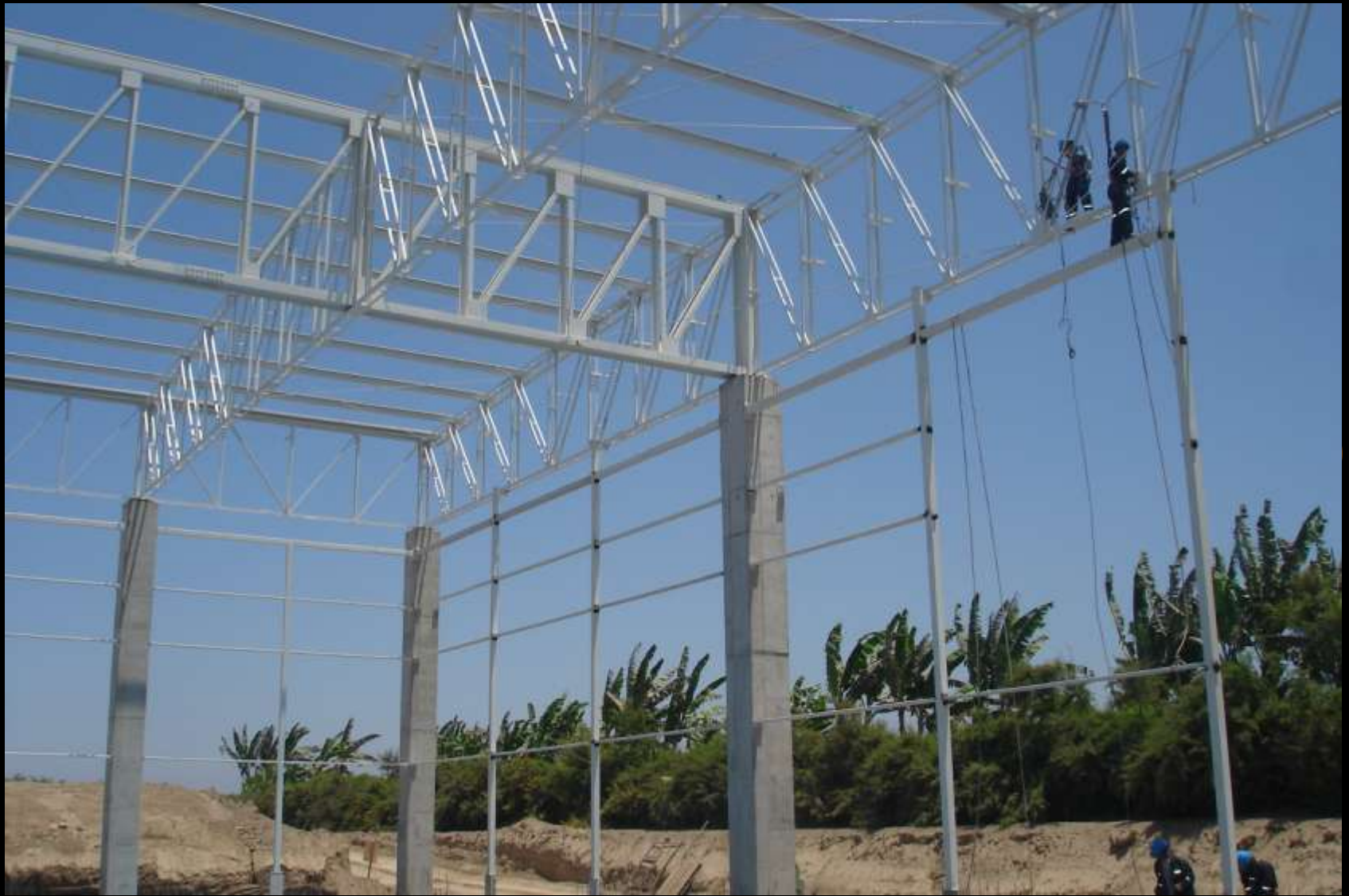
Zona de Cámaras. Columnas de 10.60m de altura.
