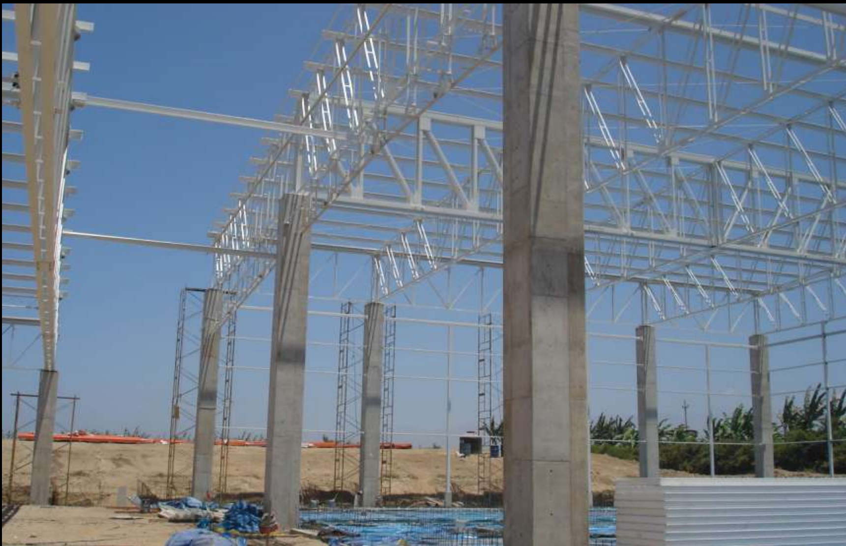
Columnas de 6.00 y de 10.60 metros de altura.
