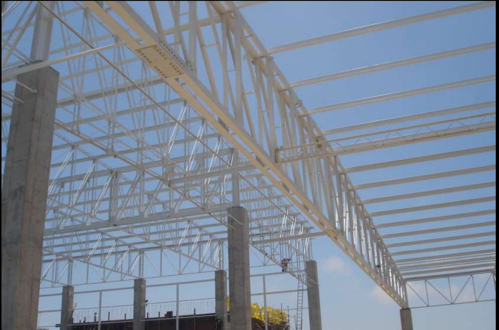
Ejes 24 y 23. Encuentro de Armaduras a distinto nivel.
