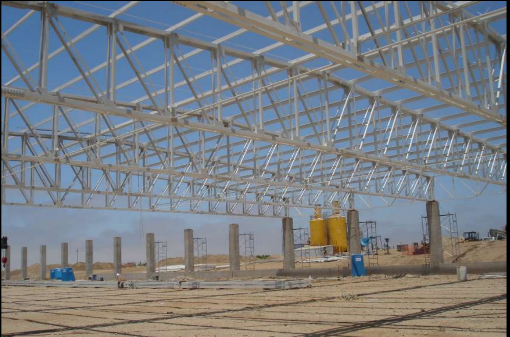
Columnas P4 con la Armadura de 50m. ya instalada.
