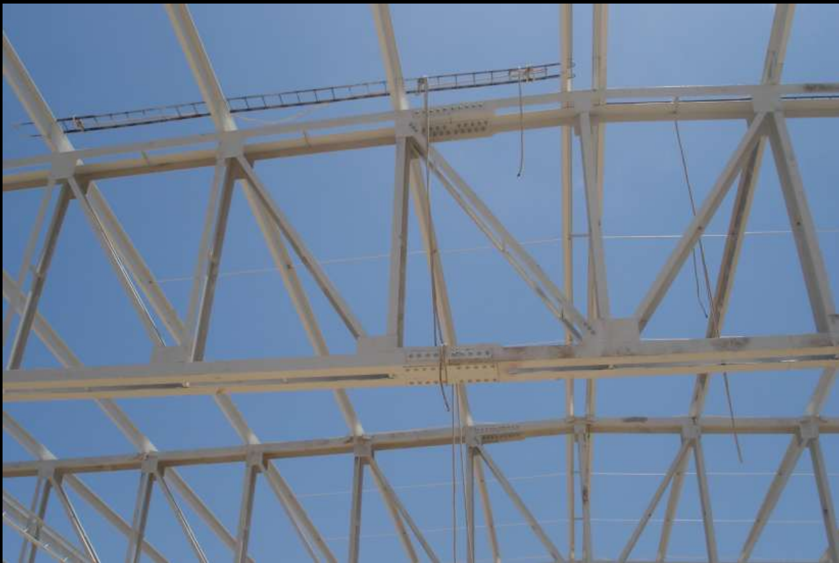
Empalme de Bridas. Armadura de 50m.
