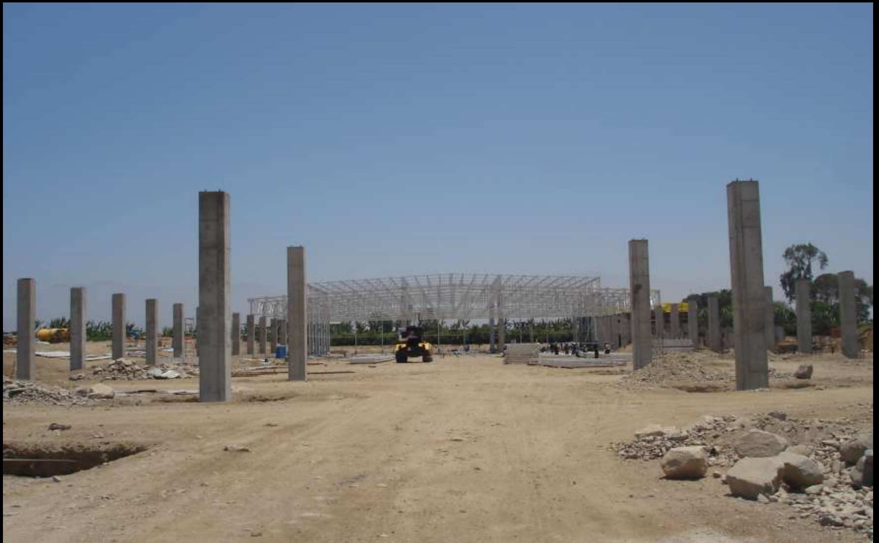
Planta Principal. Columnas ya vaciadas. En la parte superior de la foto se aprecia la zona de Cámaras de Conservación.
