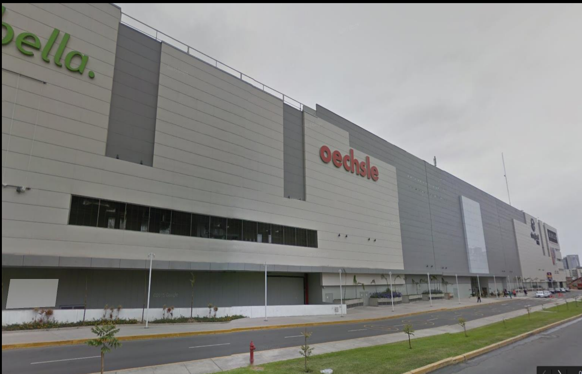
VISTA PANORÁMICA DEL CC. REAL PLAZA SALAVERRY desde la Av. Punta del Este
