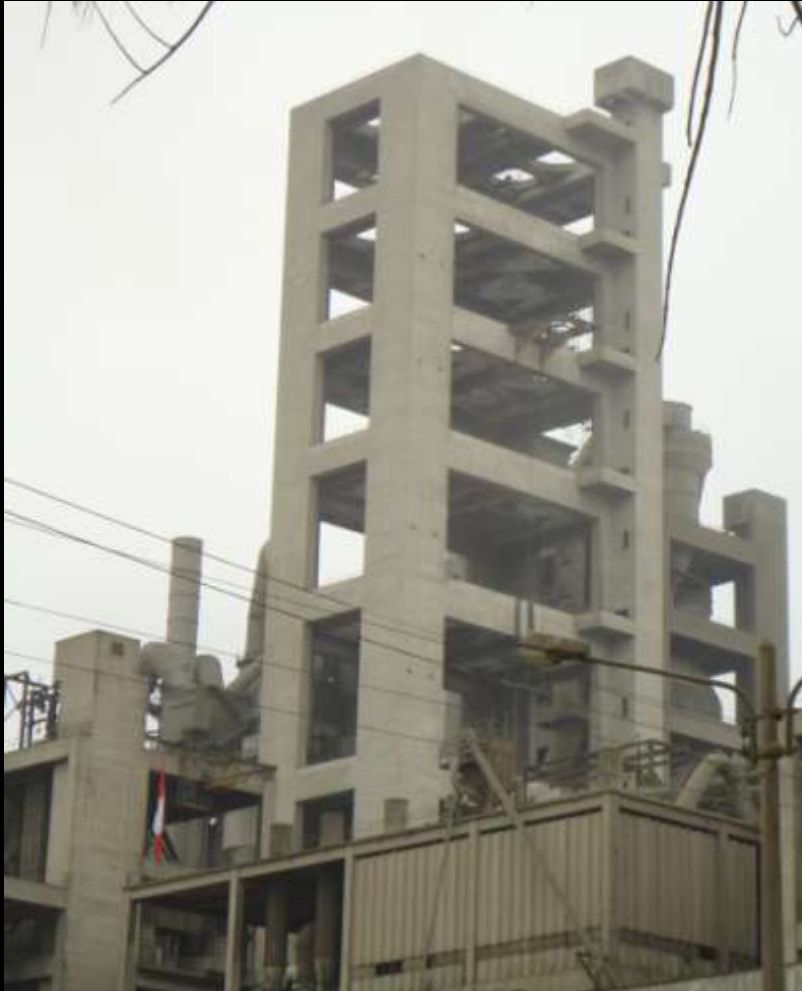
Intercambiador de calor - CEMENTOS LIMA
