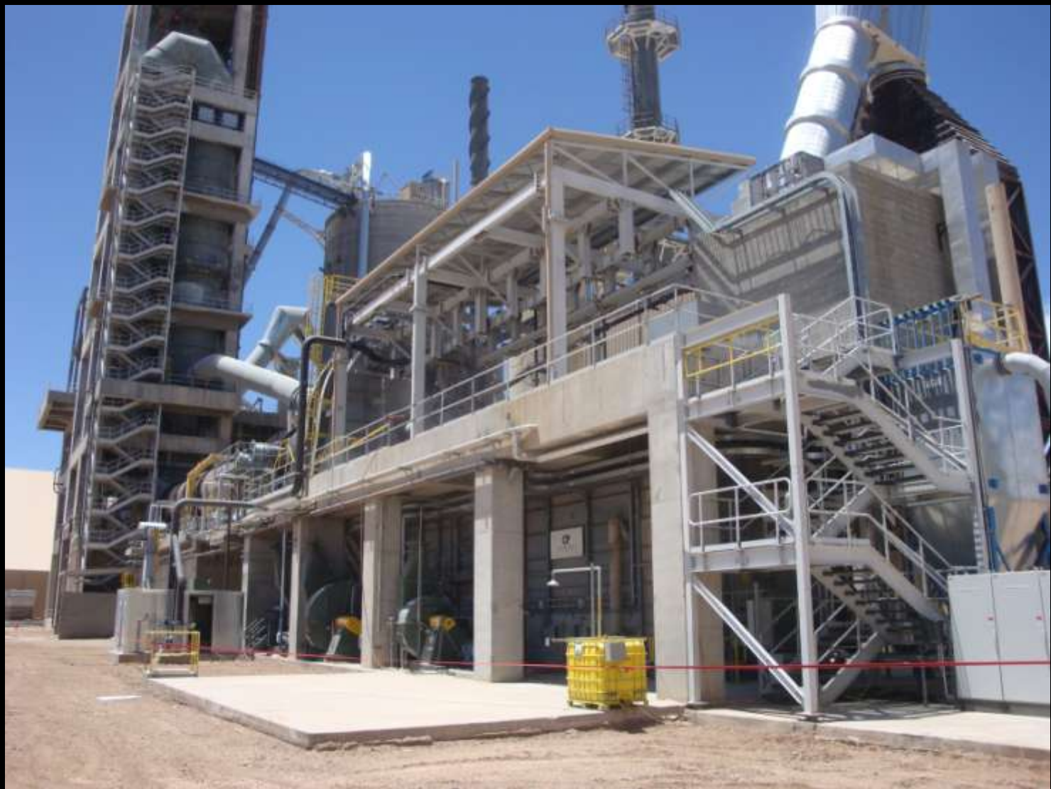
PLANTA DE CEMENTOS “DRAKE” (ARIZONA-EEUU)
