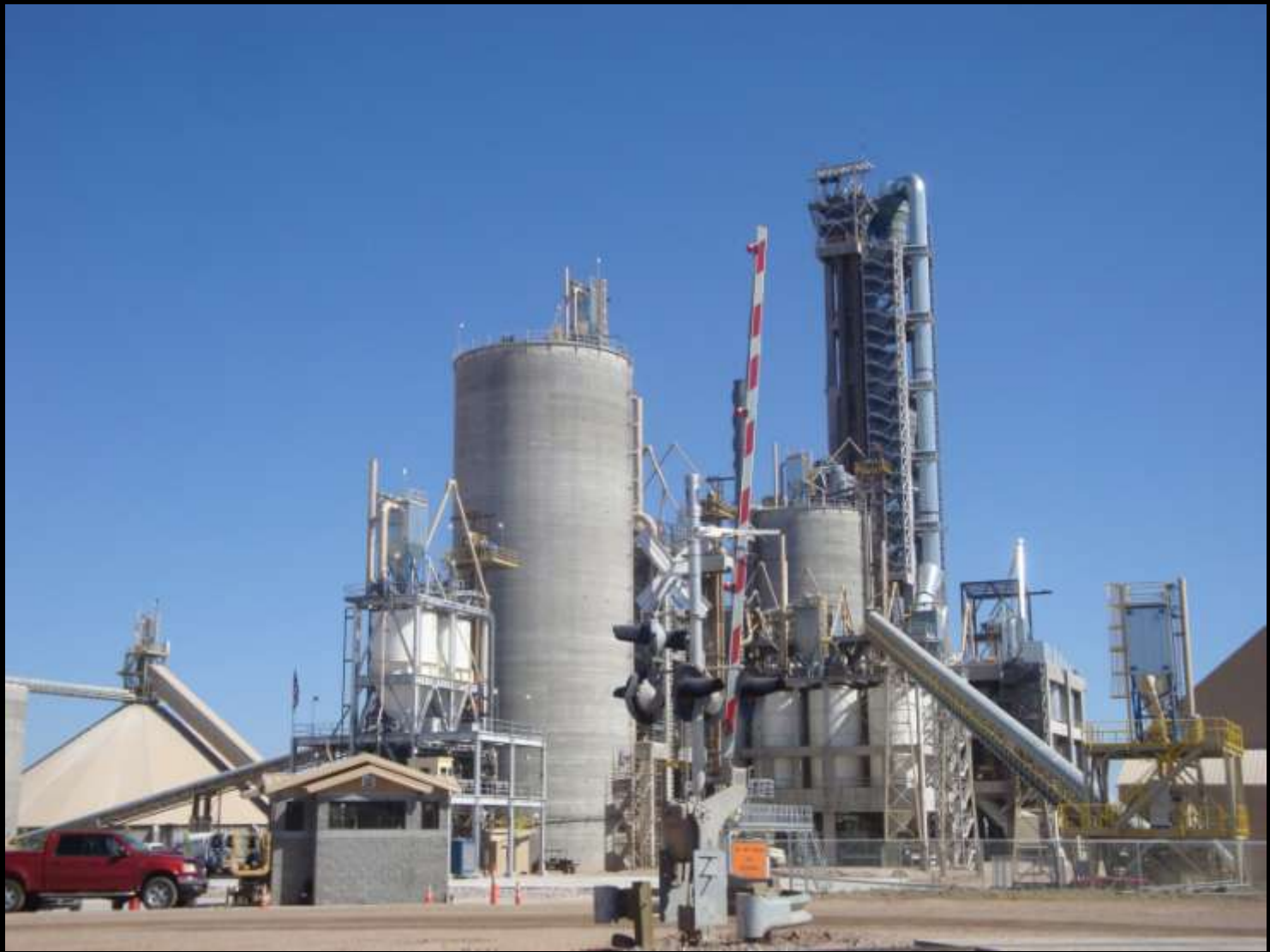
PLANTA DE CEMENTOS “DRAKE” (ARIZONA-EEUU)
