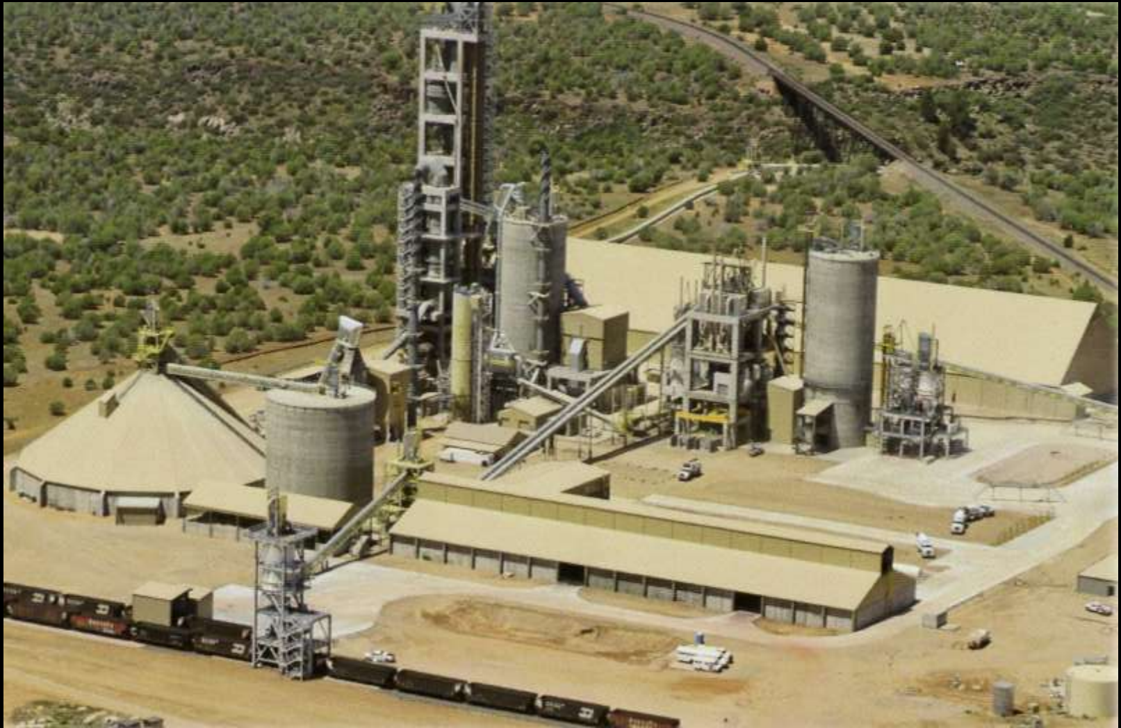
PLANTA DE CEMENTOS “DRAKE” (ARIZONA-EEUU)
