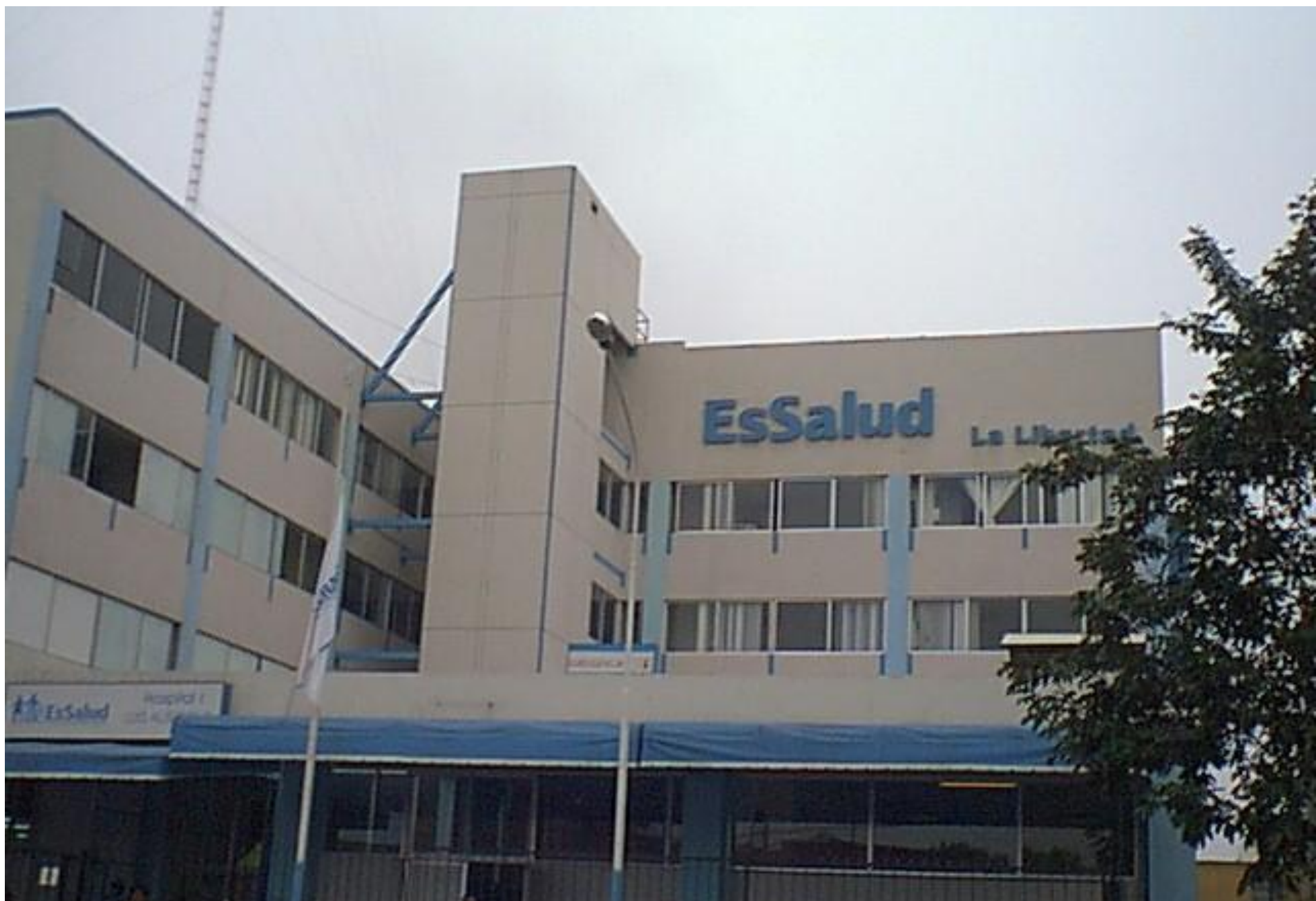
HOSPITAL ESSALUD DE LA LIBERTAD
