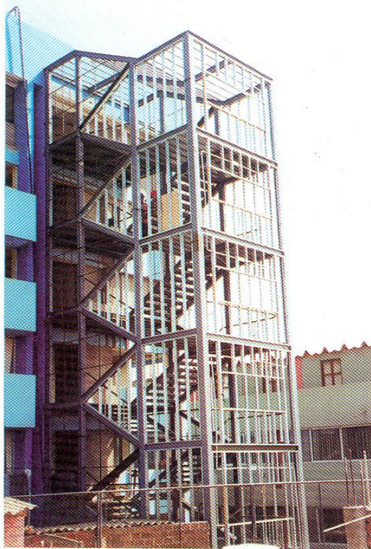
Remodelación Hospital Nylamp - Chiclayo Lateral - Escalera de Emergencia. Superboard
